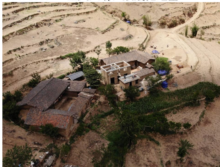
6. 16. 2019 開始焊屋架、做裝修
